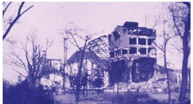
Die kriegszerstörte Stadthalle kurz vor Abbruch
