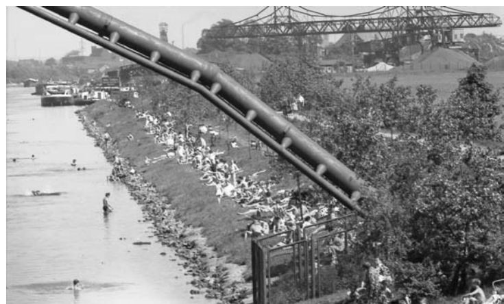
Badende am Ufer des Rhein-Herne-Kanals vor dem Werkshafen Grimberg. Die bogenförmige Rohrbrücke über den Kanal existiert schon lange nicht mehr.
