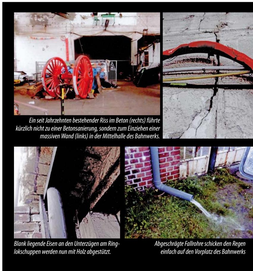
*Ein seit Jahrzehnten bestehender Riss im Beton (rechts) führte kürzlich nicht zu einer Betonsanierung, sondern zum Einziehen einer massiven Wand (links) in der Mittelhalle des Bahnwerks.*
