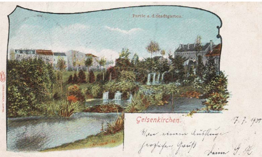
Sein Wasser erhielt der große Teich ursprünglich von den Wasserfällen der „Alten Grotte“.
