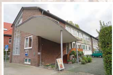
Abgesichert: das soziokulturelle Zentrum Alfred-Zingler-Haus
