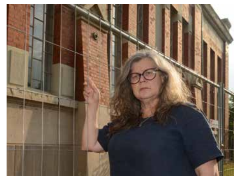
Elke Schumacher an dem Bauzaun, mit dem die Stadt aktuell die bröckelnde Fassade der Maschinenhalle sichert.
